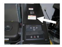
LIFT THE LID BY PUSHING DOWN ON THE LID COMPRESSING THE RUBBER GASKET WHILE UNLOCKING THE KEY. TAKE THE ELECTRICAL LOAD OFF THE GENERATOR BY SHUTTING OFF THE BREAKER. PULL THE DOUBLE POLE BREAKER BACK TOWARDS YOU, AND THE FRONT OF YOUR NEVER DARK GENERATOR.
